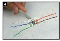
Kabel einführen und die einzelnen Adem nach der von Ihnen gewählten Belegungsvariante in den Kabelsortierer einführen.
