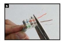
Überstehende Adern abschneiden. Trim the ends of the conductors.
